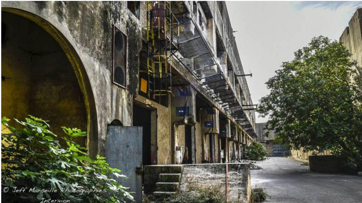
Base sous-marine allemande avant les travaux
