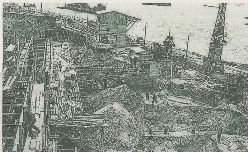
La pose des pieux de soutènement de la future base, implantés en profondeur dans la presqu'île.
